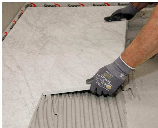
2 Einlegen einer Natursteinplatte. Aufgrund der hellen Farbe eignet sich Sopro FKM® Silver auch für die Verlegung durchscheinender Materialien.
