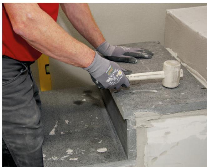
2 Verlegen einer Treppenstufe. Aufgrund der Schnellerhärtung kann eine frühe Belastung erfolgen.
