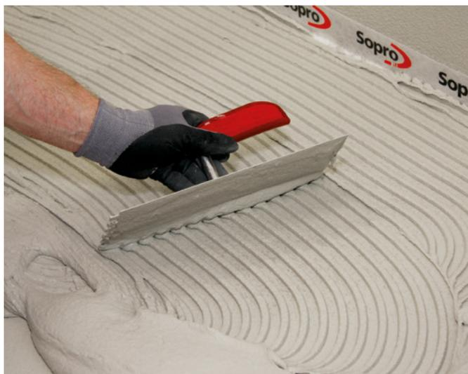
1 Aufziehen der Kontaktschicht und des Kammbetts in der Fließbettkonsistenz.
