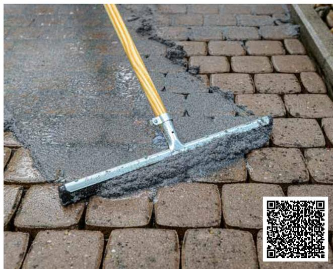
Sanierung einer Pflasterfläche mit Sopro Solitär® F 20.
