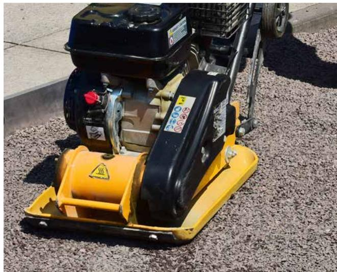
**2** Nach dem Herstellen der Tragschicht wird eine dünne Lage (~10–20 mm) aus filterstabilem Split in der Korngröße (2/5) über der gesamten Fläche verteilt und mit einer Rüttelplatte zum gründlichen Verschließen von Hohlräumen in der Tragschicht kompaktiert.
