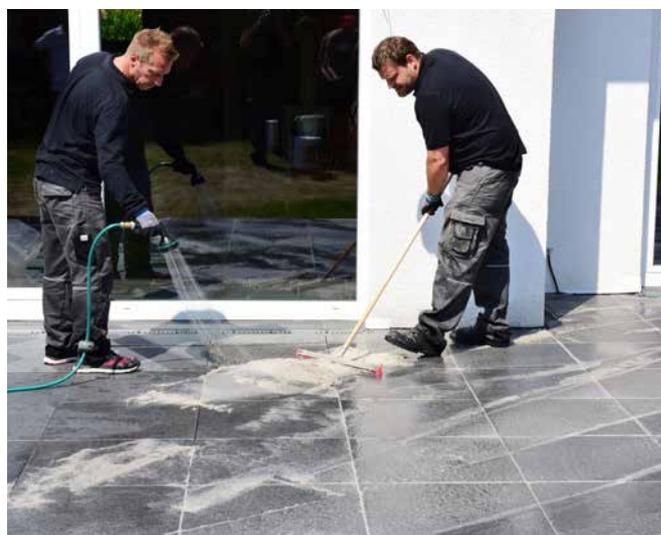
**12** Material mit dem Wassersprühstrahl befeuchten, in eine geschmeidige Konsistenz bringen...
