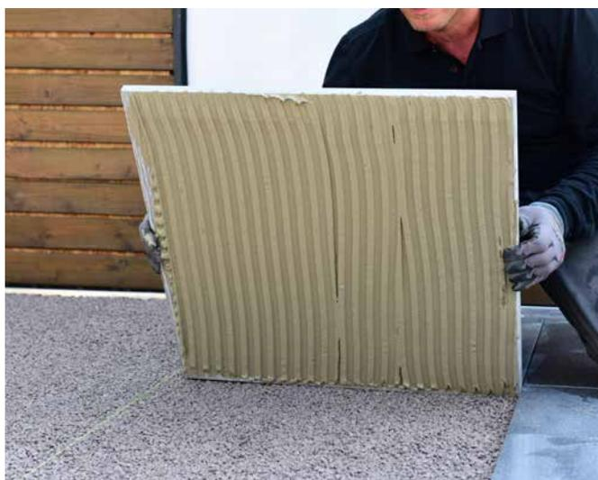
**5** Die Verlegung keramischer Terrassenplatten mit einer Stärke  $\geq 2$  cm erfolgt im Buttering-Verfahren durch das Auftragen eines C2 S1 Fliesenklebers, z. B. Sopro's No.1 400, mit mind. einer 10 mm Zahnkelle auf die Fliesenrückseite.
