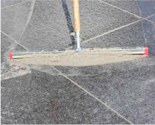
13 ... und mittels Gummischieber in die Fuge einbringen.
