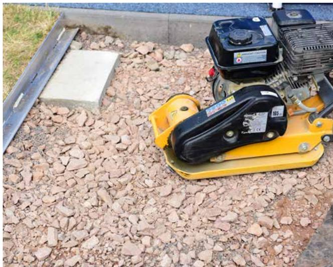
**1** Die Konstruktion ist mit einer umlaufenden, tragfähigen, festen Randeinfassung zu versehen (z. B. Randsteine in Fundament aus Sopro Rapidur® M8). Die Schotterschicht gewährleistet die Frostsicherheit, ist mind. 30 cm dick auszuführen und lagenweise zu verdichten, um Setzungen innerhalb der Randeinfassung zu vermeiden. Die Schotterschicht muss dabei bereits ein ausreichendes Gefälle aufweisen.
