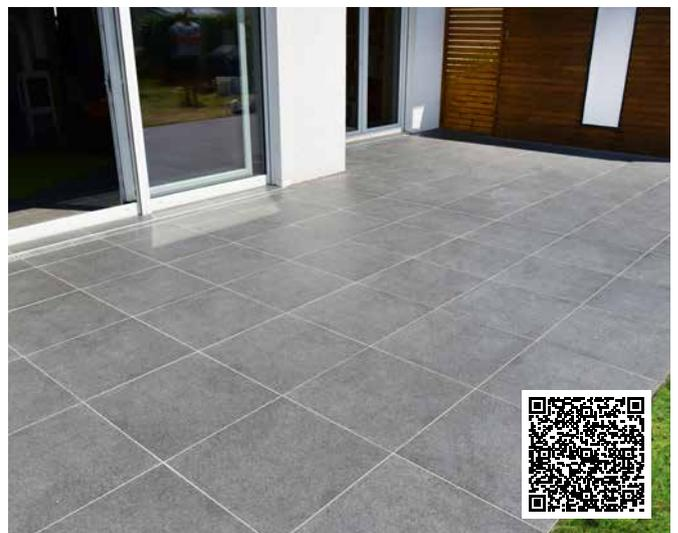
18 Die verfugte Oberfläche ist nach 24 Stunden begehbar.
