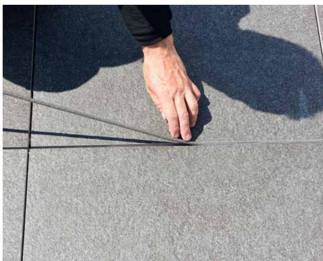
**9** Eingeplante Bewegungsfugen sind mit einer Hinterfüllschnur zur Vermeidung einer Dreiflankenhaftung zu füllen.
