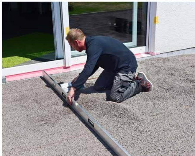
**4** Die Fläche wird mittels eines Richtscheits gleichmäßig eben mit einer Bettungsdicke von 30–50 mm abgezogen, mittels Glättkelle nachgearbeitet und für die Verlegung vorbereitet.
