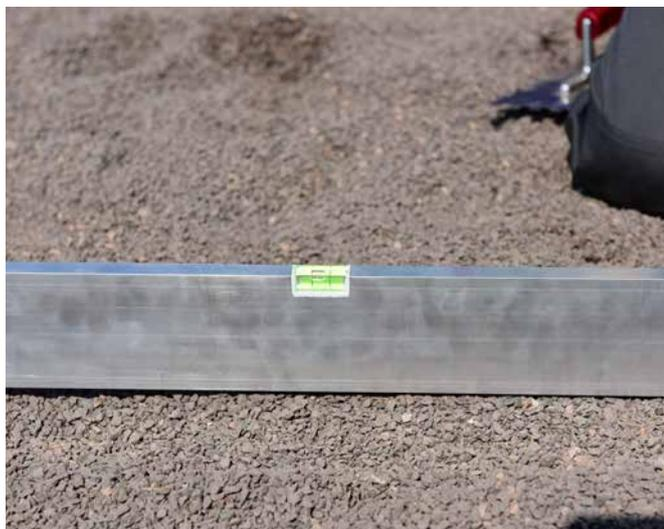
**3** Die Höhe der Tragschicht und die Ausbildung eines Gefälles von mind. 1,5 % sind stets zu kontrollieren.
